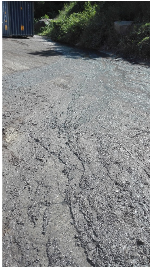
Débouché du dalot sur la piste et écoulements vers la ravine à travers la piste
