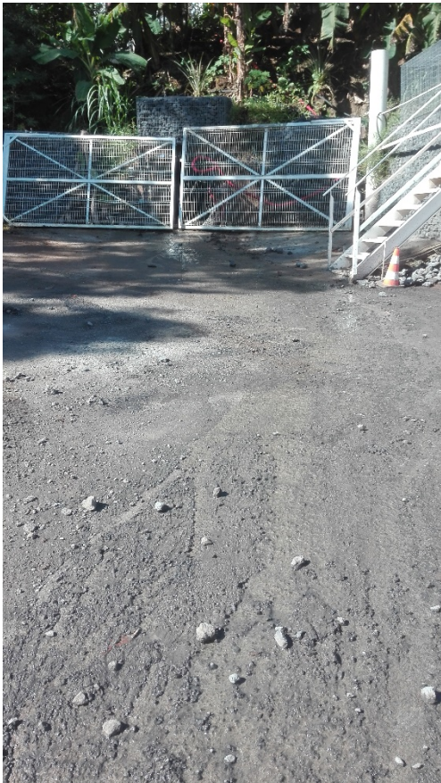
Débouché du dalot sur la piste et écoulements vers la ravine à travers la piste
