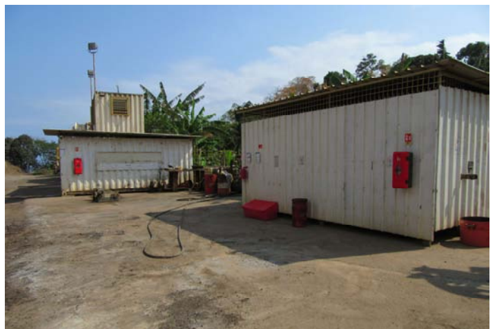
Aire étanche et containers
